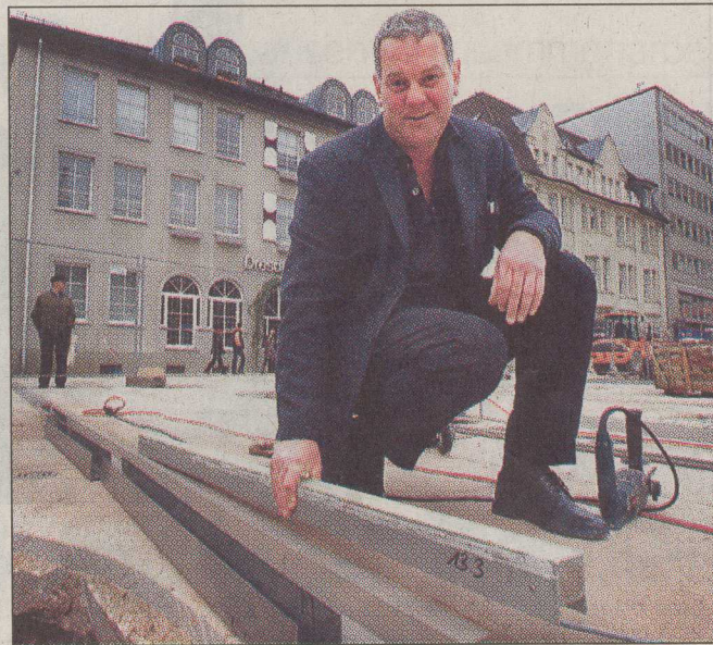
Gestern begann der Einbau der Lichtbänder auf der Rathausplatz-Baustelle. (WR-Bild: Raith)
